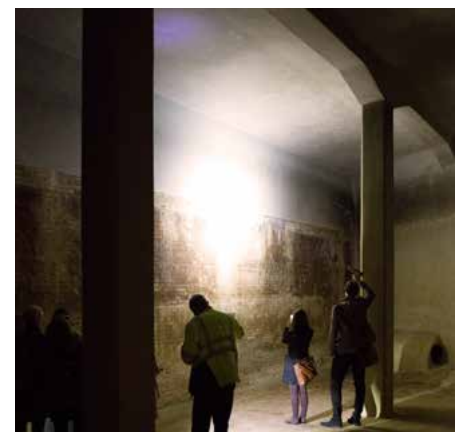
↑ Das ehemalige Trinkwasserreservoir der Stadt Zürich stammt aus dem späten 19. Jahrhundert und wurde Ende der 1970er-Jahre ausser Betrieb genommen. Quelle: Tim Klausner
