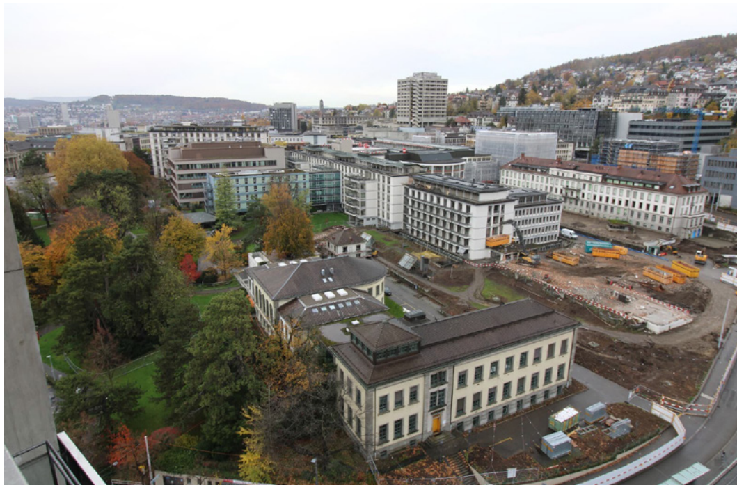
← Baustellen-Webcam vom 14. November 2022: Die ersten Gebäude entlang der Gloriastrasse sind bereits verschwunden.
