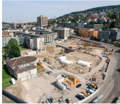
↑ Baustellen-Webcam vom 30. Mai 2023. Die alten Gebäude auf dem Baufeld sind verschwunden.
