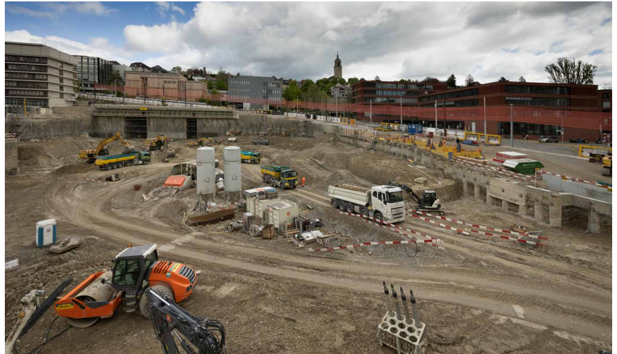
↑ Baugrube für die Neubauten: Das USZ minimiert Lärm, Erschütterungen und Staub.
