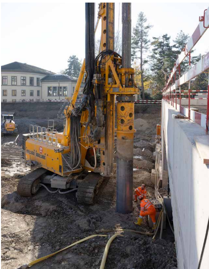
↑ Diese Drehbohrmaschine bohrt die Pfähle für die Bohrpfahlwand in den Boden, ohne Lärm und Erschütterungen zu verursachen.
